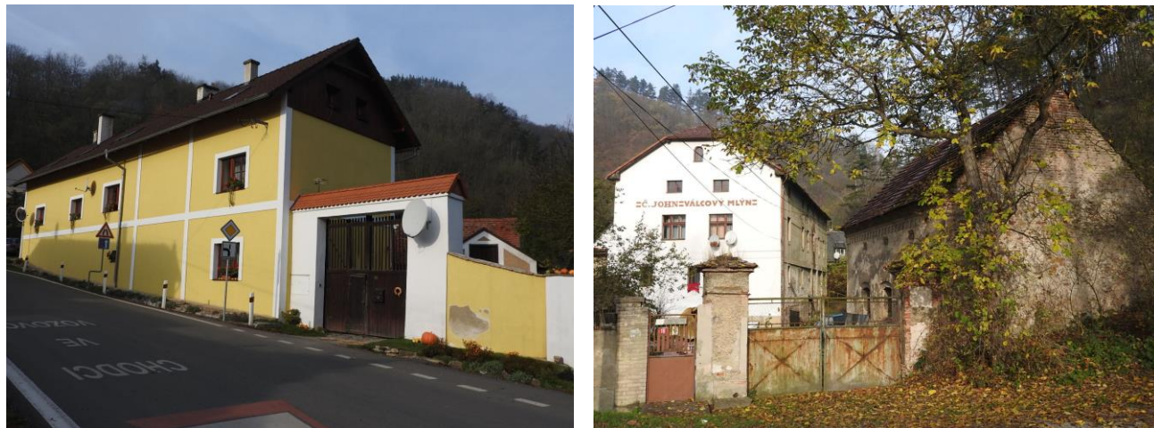
Obr. 2.2.39: Při stavební úpravě domu ve svahu bylo vhodně užito členění fasády pomocí lizén.
