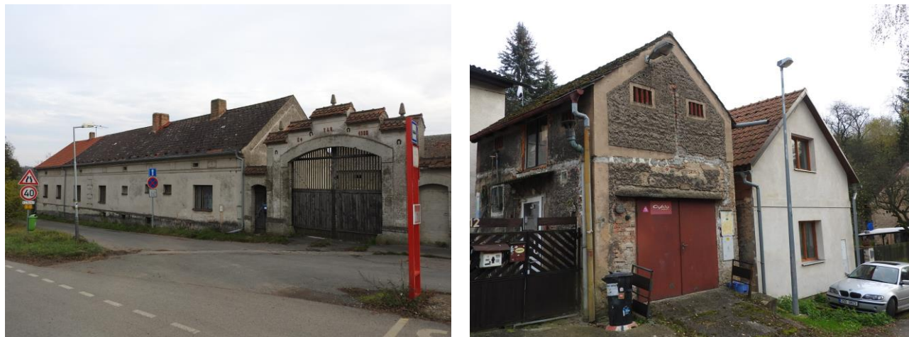
Obr. 2.2.322, 2.2.323: Podélně orientovaná přízemní budova statku se sedlovou střechou v horní části sídla. Nejvýrazněji působí zděná brána se stupňovitým klenutím (vpravo) a dvojice sedlově zastřešených staveb má podobné hmoty i orientaci štítů. Výška je dána stísněnými terénními poměry v údolí (dolní část sídla). (Foto vše: L. Klouda)
