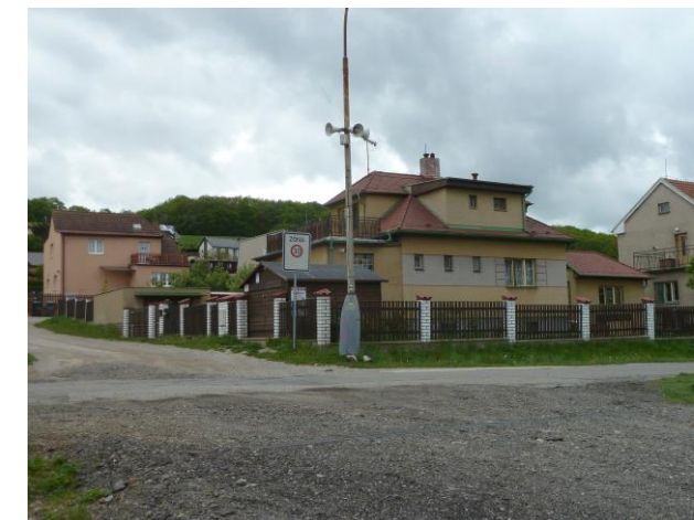
Obr. 2.2.349a, 2.2.349b, 2.2.349c: negativní dominanty bytových domů v severní části sídla (Foto vše: L. Klouda)
