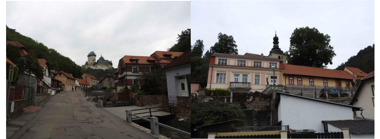
Obr. 2.2.20 (předchozí strana) a Obr. 2.2.21: Hrad Karlštejn nad zástavbou Budňan v údolí Budňanského potoka. Obr. 2.2.22: Zástavba ve svahu pod kostelem sv. Palmacia.
