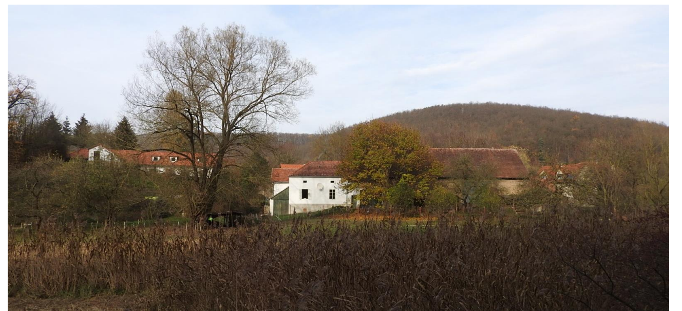
Obr. 2.2.252: Hospodářský Dvůr v drobné enklávě Dolní Roblín působí v krajinném kontextu - údolí Karlického potoka harmonicky. (Foto: L. Klouda)
