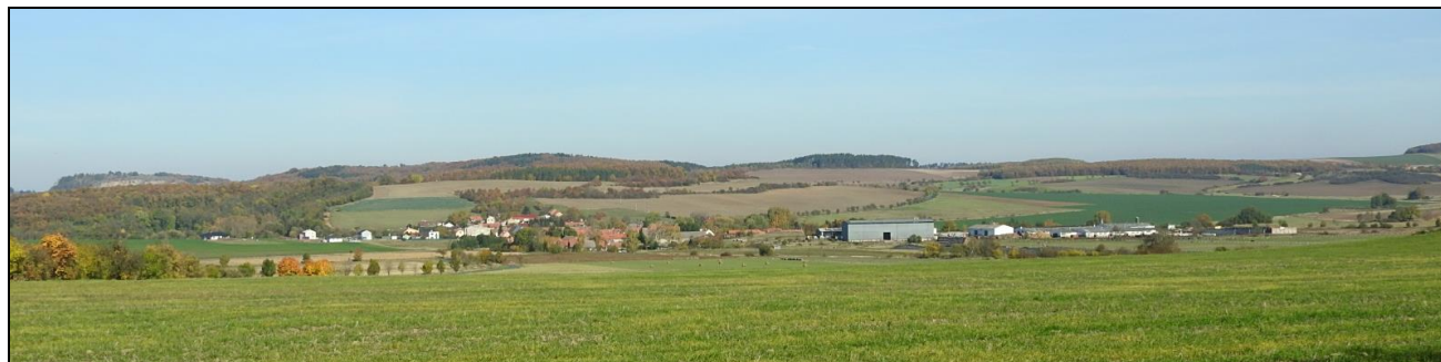
Obr. 2.2.148a: Bykoš v pohledu v pohledu od jihozápadu (křižovatka silnic do Neumětel a Lážovic); vpravo v popředí areál zemědělské velkovýroby s dominantním skladovým objektem (Foto: I. Vorel)
