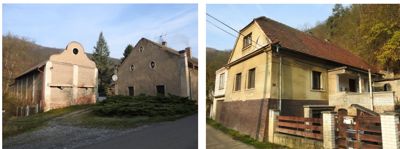
Obr. 2.2.98, 2.2.99: Hospodářské budovy statku (vlevo). Výtvarně i hmotově hodnotnější je stavba vlevo s barokními křivkami štítu a členěnou fasádou. Vpravo vesnický dům s patrovou římsou štítové stěny a se sedlovou střechou zakončenou polovalbičkou. Stavbu poněkud degradují pozdější úpravy a užití různých materiálů. Nevhodně působí zejména přístavba nad boční garáží. (Foto vše: L. Klouda)
