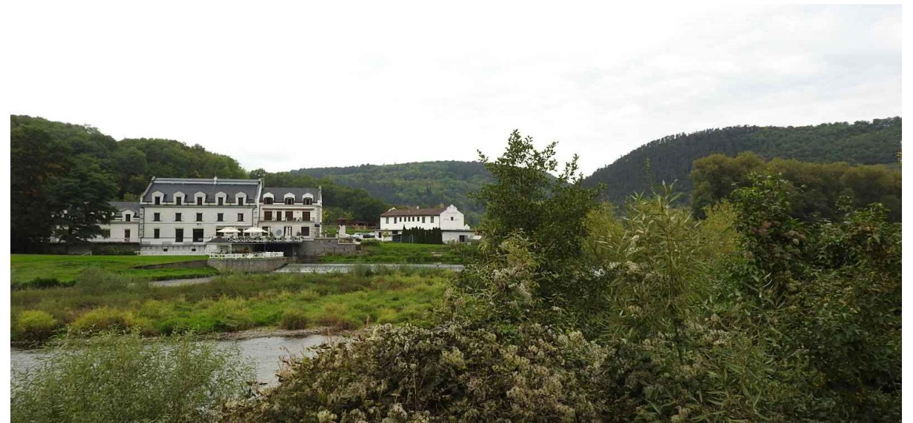
Obr. 2.2.51: Hotel Mlýn Karlštejn v pohledu z protějšího břehu řeky. Původní stavba si zachovala hmotu, zastřešení, nárožní bosáž i charakteristické zvýraznění štítů. Nepůvodní vikýře citlivě reagují na rytmické rozvržení oken. (foto: L. Klouda)
