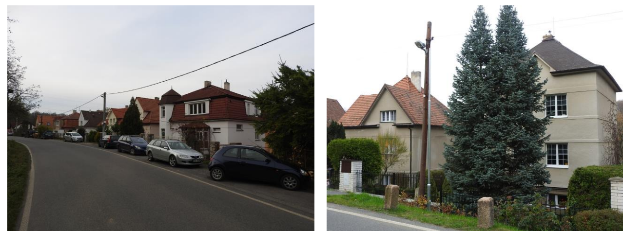
Obr. 2.2.274: Hmotově jednotná vilová zástavba s četnými renovacemi při průjezdní cestě. Obr. 2.2.275: Projev vilové zástavby ve svahu výrazně formuje okrasná zeleň. (Foto: L. Klouda)
