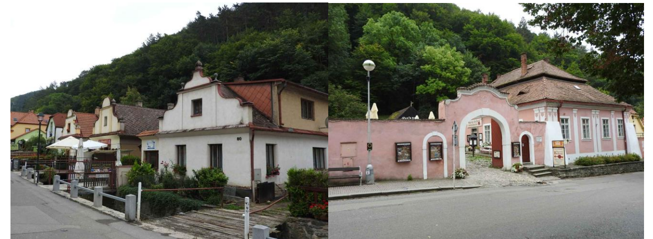
Obr. 2.2.23: Jednotně působící domky s pseudobarokními štíty shodně orientovanými do uličního prostoru. Obr. 2.2.24: Barokní fara s dominantní mansardovou valbenou střechou a zděnou bránou.
